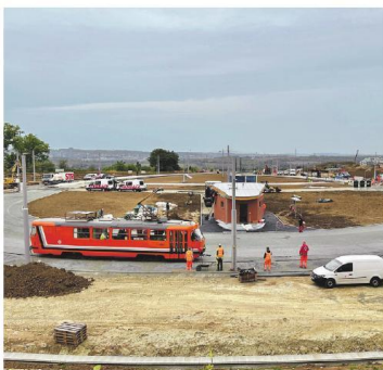
POMERANČ NA TRATI. Měření tramvaji zvané Pomeranč proběhlo po kolejích mezi Holyní a Slivencem, které dopravní podnik zprovozní v pátek. (cie)
