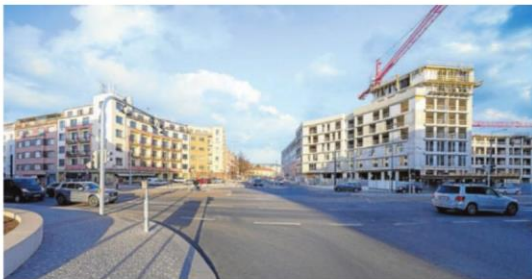
BASILEJSKÉ NÁMĚSTÍ. Prostor prošel obnovou a vyrůstá zde Parková čtvrť. Foto: Central Group
