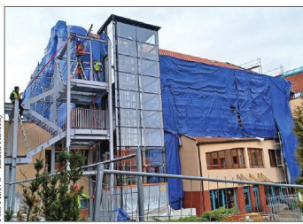
Práce na přístavbě k domovu seniorů v Mladé Boleslavi.
